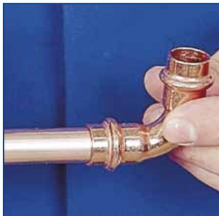
Le tube est inséré dans le raccord, en tenant compte du marquage de la profondeur d'insertion préalablement effectué, jusqu'à ce qu'il soit arrêté dans sa progression.
