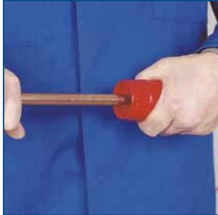
Les tubes doivent ensuite être soigneusement ébavurés à l'extérieur et à l'intérieur. Les tubes recuits doivent, en outre, toujours être calibrés avant de poursuivre le traitement.
