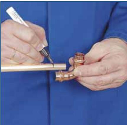
Avant le montage, la profondeur d'insertion du raccord est marquée sur le tube (pour les mesures, voir également le tableau ci-dessous). Ainsi, tout déplacement peut être détecté avant le sertissage.
